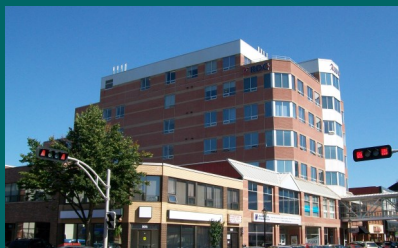
5e étage, 119 rue Kent, Charlottetown , Î.-P.-É.
