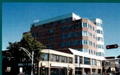
5e étage, 119 rue Kent, Charlottetown, Î.-P.-É.
